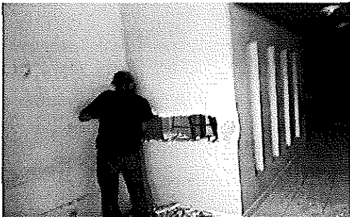
5.- DEMOLICION DE MURO EXISTENTE
